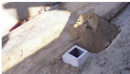
En caso de que no se trabaje en la arqueta en cuestión, se protegerá. En la imagen se muestra cómo una arqueta prefabricada se encuentra sin proteger ni señalización en un momento en el que los trabajadores se han ido a almorzar. Se recomienda evitar este tipo de actitudes.
