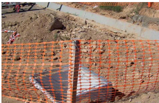
Balizamiento de la arqueta de manera obligatoria.
